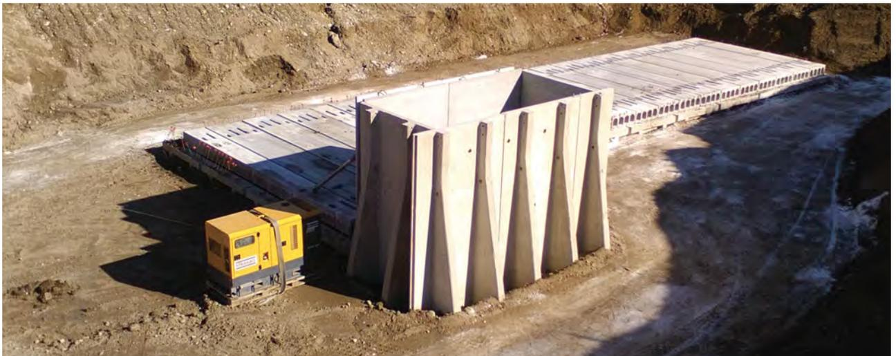
Le **vasche di laminazione Paver** realizzate componendo gli elementi prefabbricati, sono in grado di accumulare l'acqua riducendo l'infiltrazione durante gli eventi di pioggia più intensi, comportandosi come un ammortizzatore idraulico.
