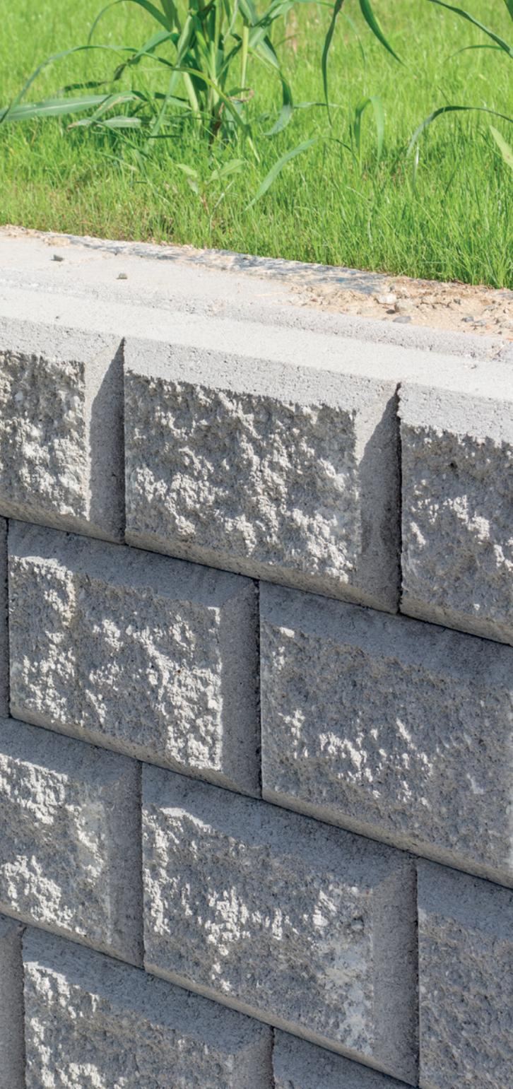
MURO A SECCO INCLINATO DI 8°
