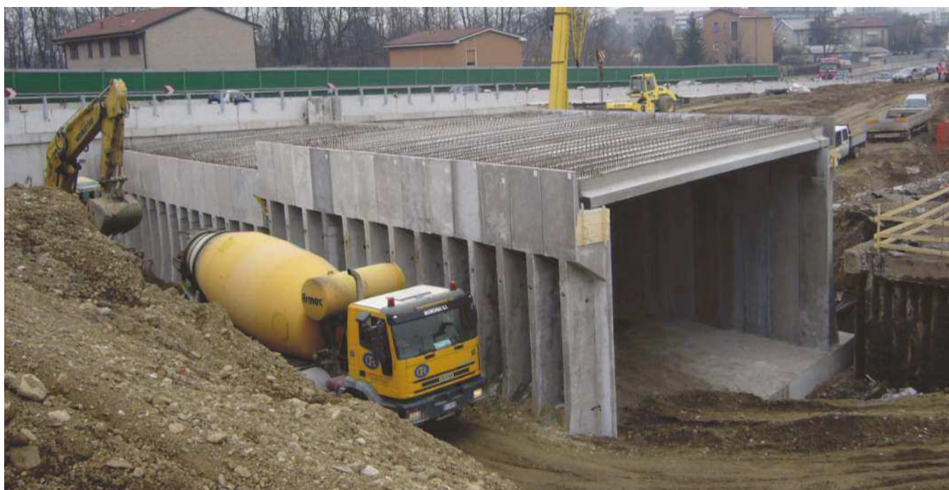
Monza / Galleria artificiale scatolare con impalcato in c.a.p. a solettone _ 2012
