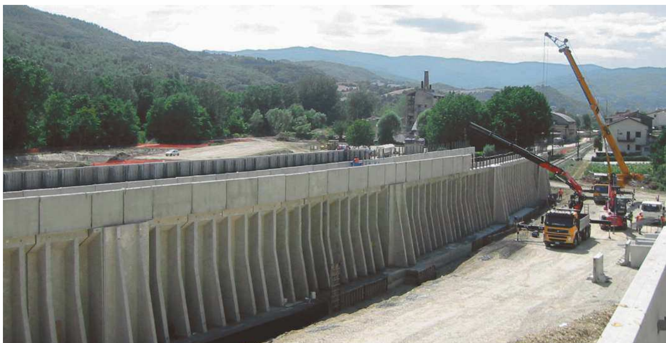
Bibbiena (FI) / Galleria artificiale scatolare ferroviaria _ 2007
