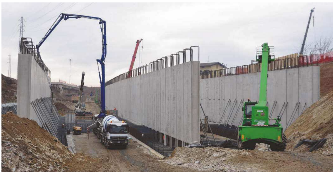
Copreno (MB) / Galleria artificiale scatolare per collegamento autostradale Dalmine-Como-Varese _ 2015
