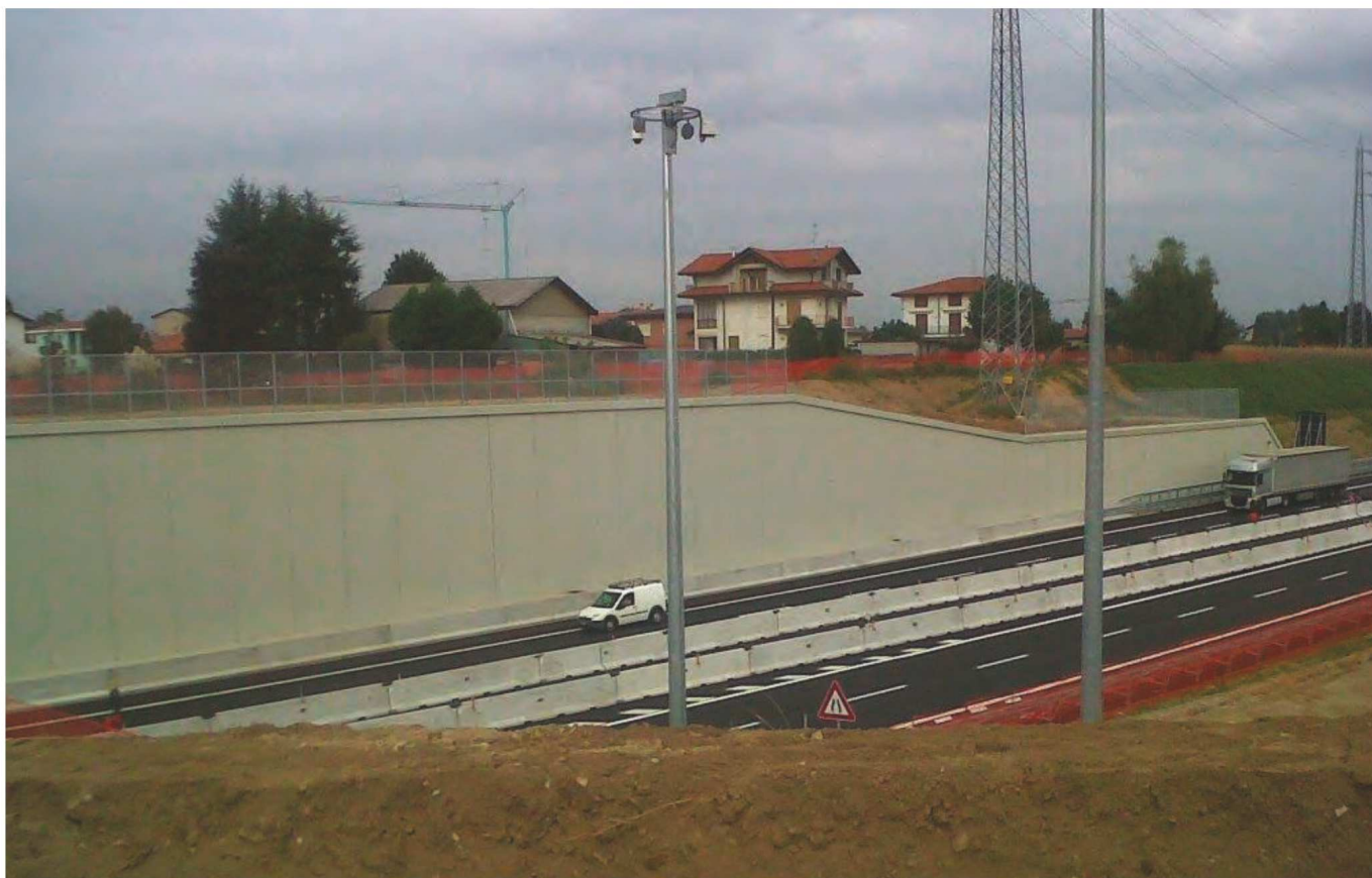
Autostrada pedemontana Lombardia - tratta B1 svincolo di Lomazzo - Cermenate
