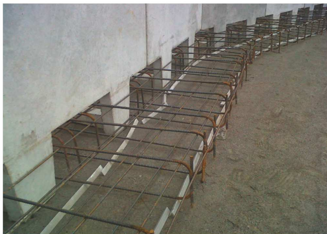
Autostrada BRE.BE.MI. - Rivolta d'Adda - BG
