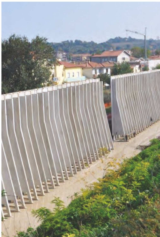
Autostrada A14 / tratto Rimini Nord - Cattolica
