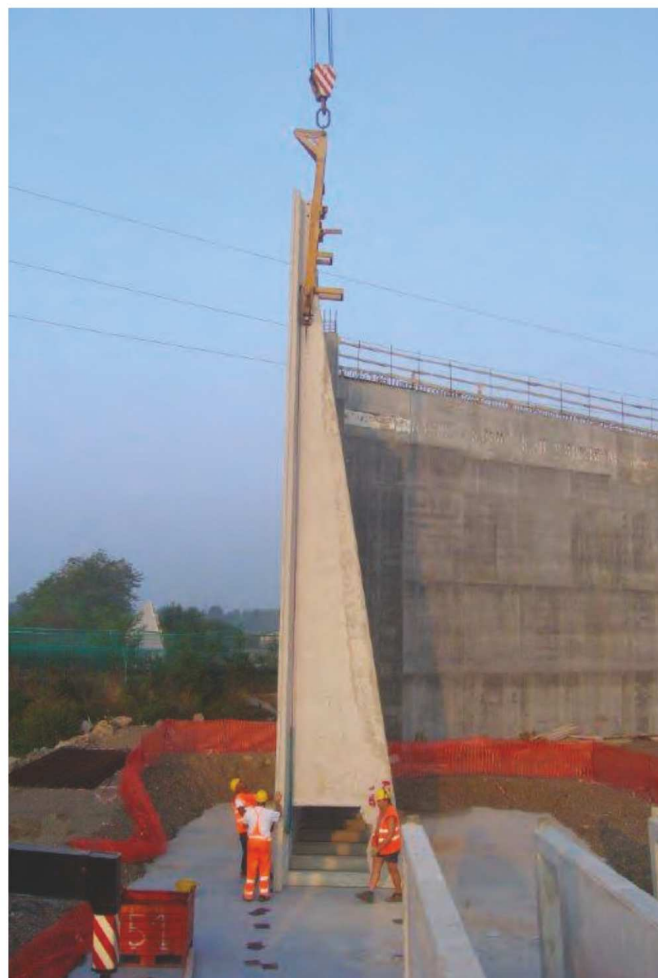
Raccordo Autostradale A4-A21 / Montichiari - BS
