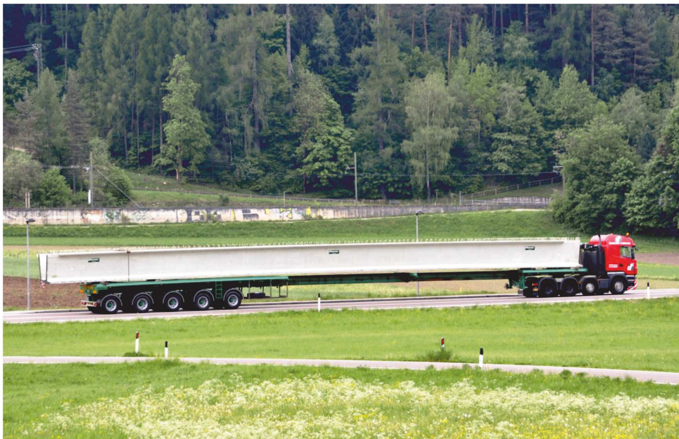
San Lorenzo di Sebato (BZ) / Ponte "Peintner" sul Rienza, SS49 al km 29,15 - travi UHP160 - L=33,50 m
