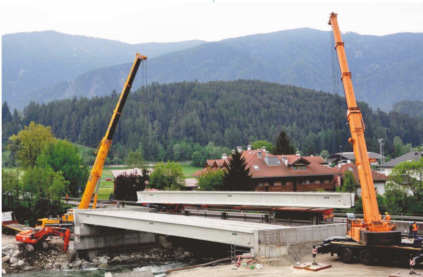
San Lorenzo di Sebato (BZ) / Ponte "Peintner" sul Rienza, SS49 al km 29,15 - travi UHP160 - L=33,50 m
