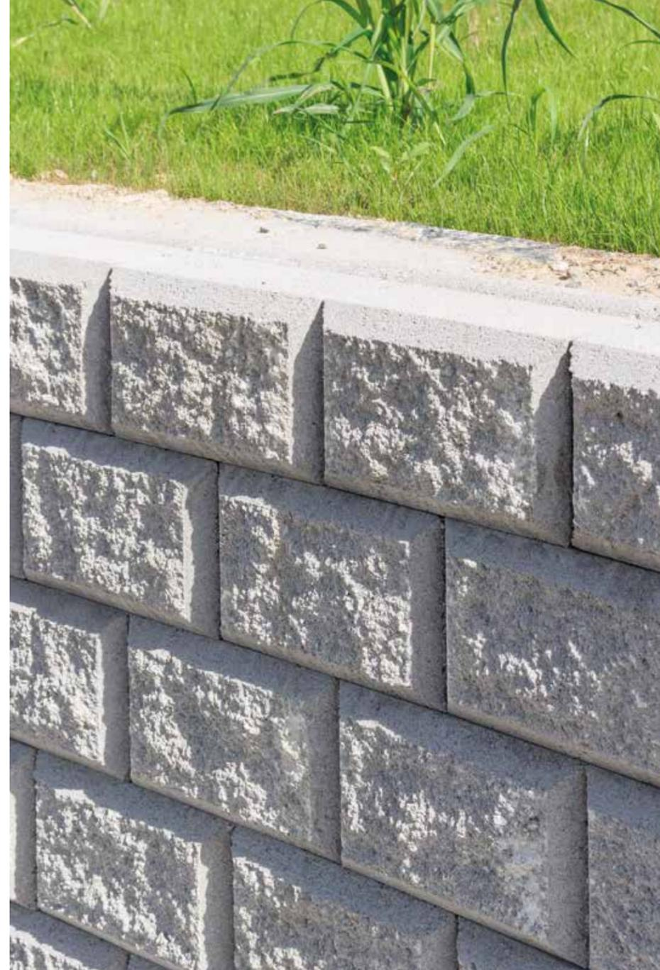
MURO A SECCO INCLINATO DI 8°
