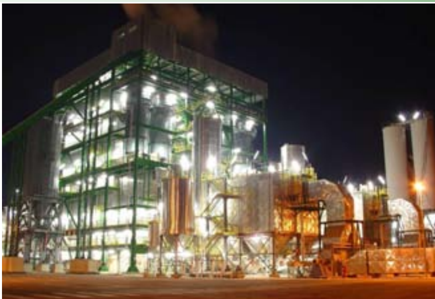
Impianto di Strongoli - KR (46,0 MW)
