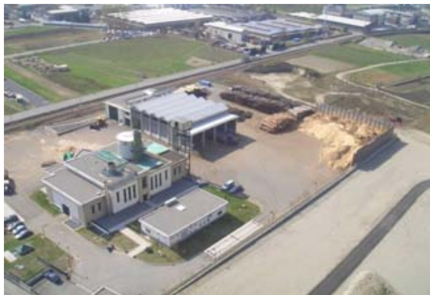
Impianto di Tirano – SO (1,1 MW)
