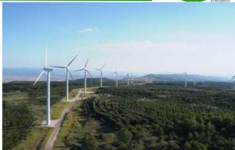
Impianto di Sa Turrina Manna – SS (23,8 MW)
