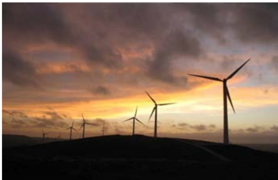
Impianto di Bagno Nasco – TP (9,3 MW)
