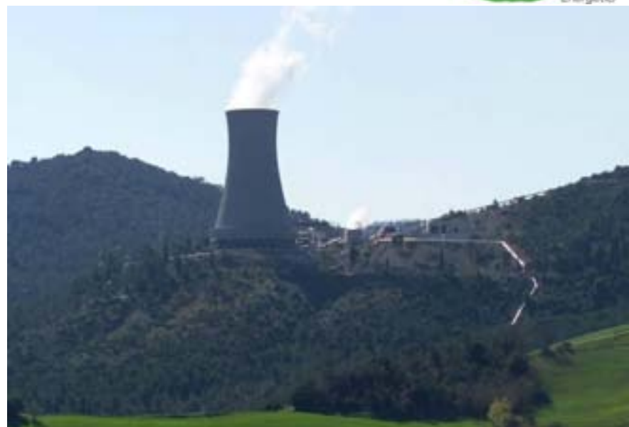
Impianto di Nuova Gabbro – PI (20,0 MW)
