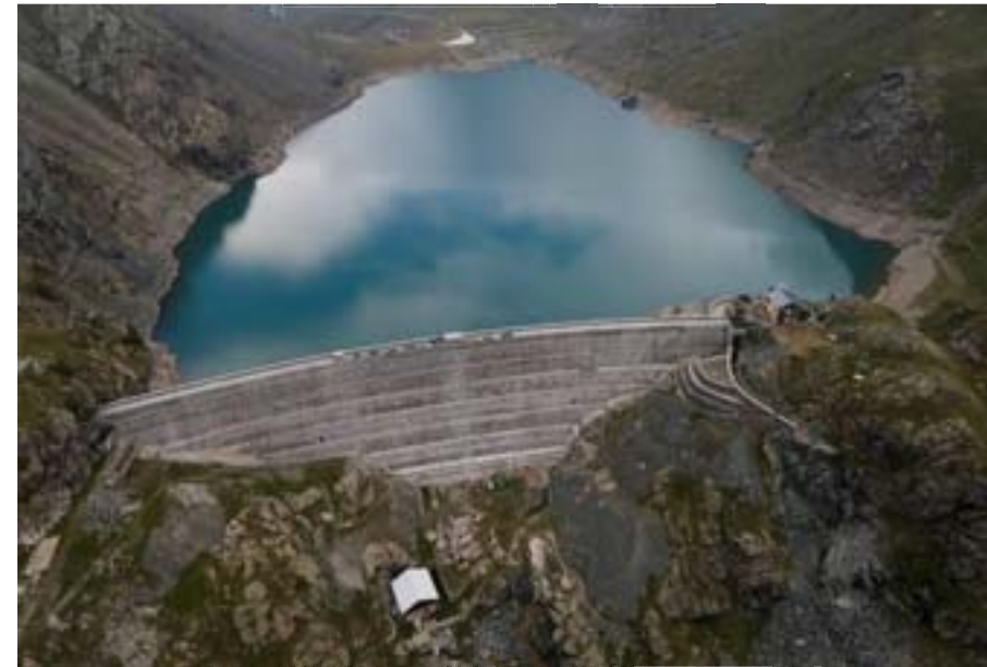
Impianto di Gressoney Gabiet - AO (11 MW)
