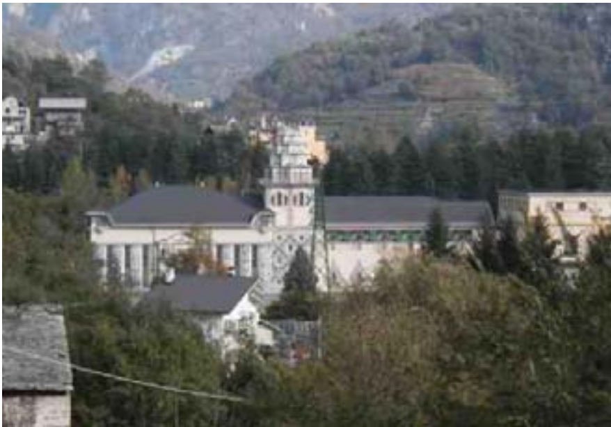
Impianto di Crevola – VCO (53 MW)
