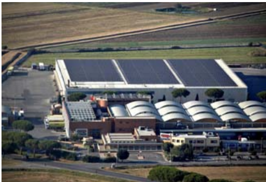
Impianto N° 9650 – LI (0,42 MW)
