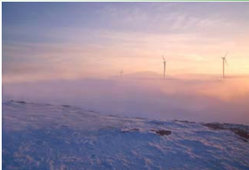
Impianto di Monte Prezza - AQ (35,7 MW)
