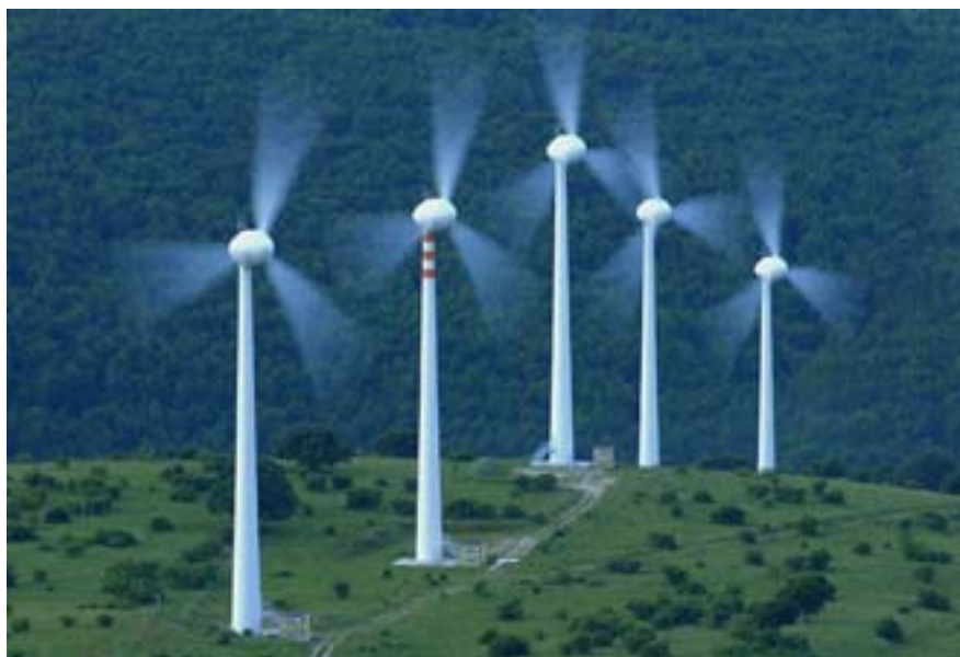
Impianto di Castiglione 2 – CH (15,8 MW)
