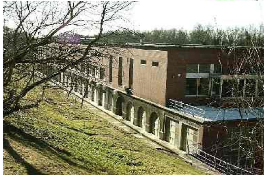
Impianto di Vizzola – VA (30 MW)
