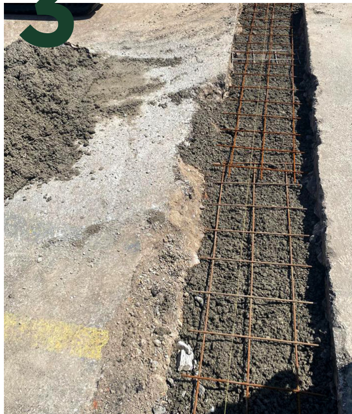
Stesura del calcestruzzo di fondazione con rete per il successivo inghisaggio dei contenitori per i Lingotti LED
