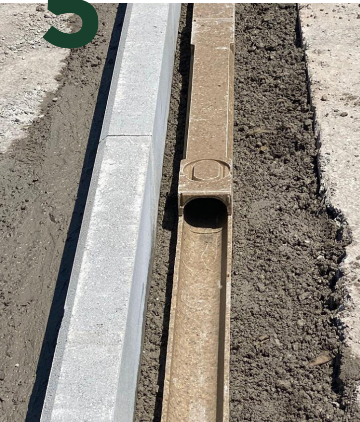
Montaggio della doppia canalina per passaggio cavi
