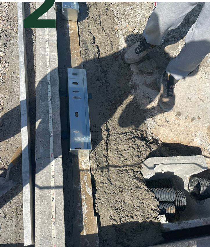
Montaggio dei contenitori sulle canaline che fanno da passacavi
