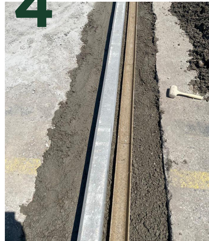
Montaggio della prima canalina che serve per realizzare il cavidotto per il Lingotti LED
