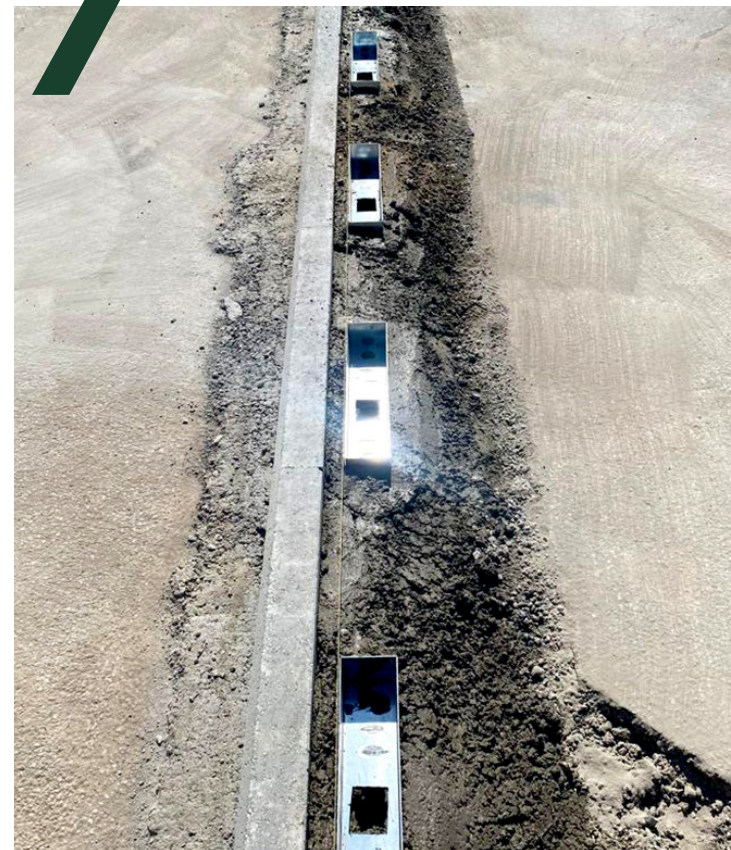
Particolare dei contenitori montati per un primo inghisaggio
