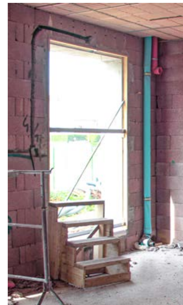
3 Apertura con falso telaio montato.
