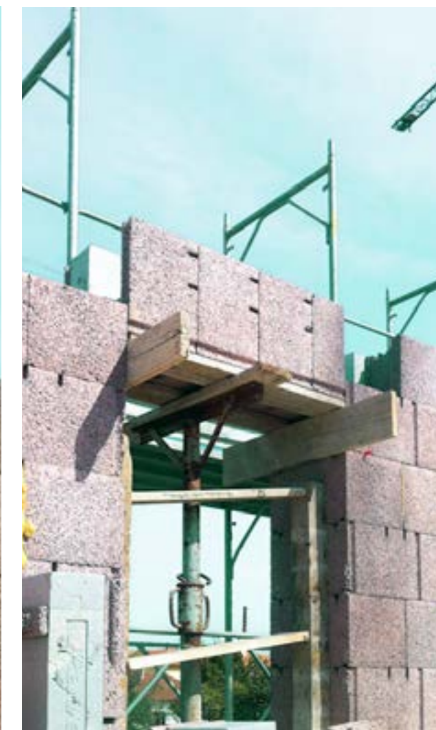
C Soluzione architrave realizzata con blocco jolly posizionato in verticale.
