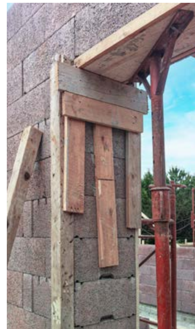
A Soluzione architrave realizzata con blocco corrente.
