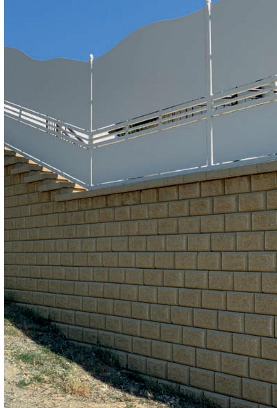
MURO A SECCO INCLINATO DI 8°
